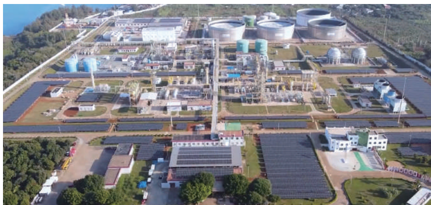
图 30 涠洲岛5MW/10MWh构网型储能项目
